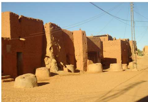
Emergences signalant le canal souterrain de la foggara
