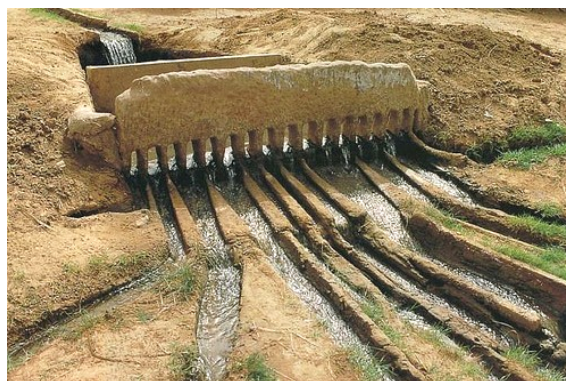
Peigne répartiteur de l'eau de la foggara
